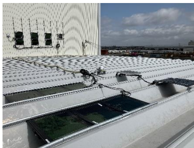
実証実験設備の取付状況
